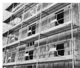
Montage et démontage d'échafaudages
