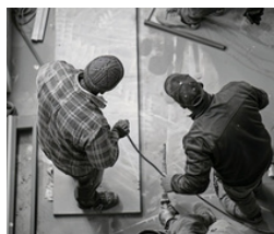
Ravalement de façade
